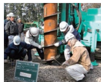
STEP 1 杭打ち機セット
