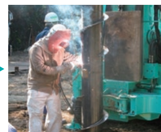
STEP 3 現場円周溶接
