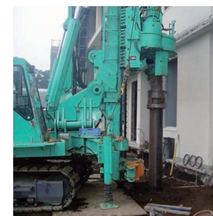
耐震補強工事
