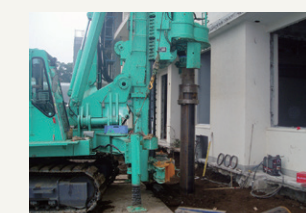
耐震補強工事
